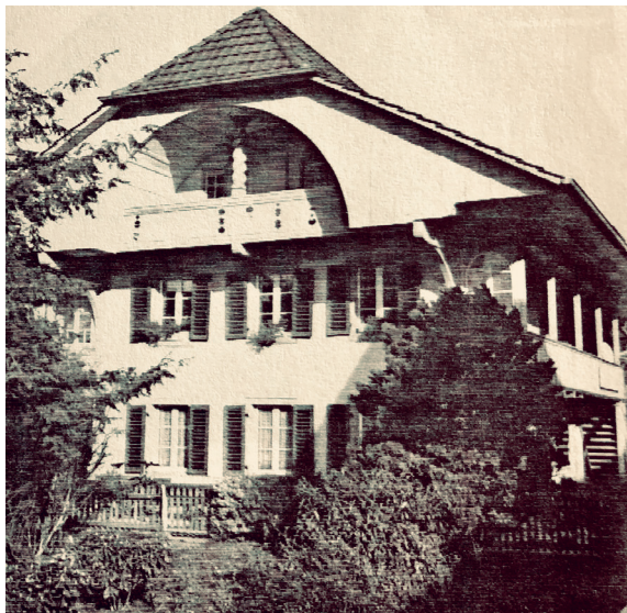
Spenglermeister-Rupp-Haus mit Vorgarten gegen S
