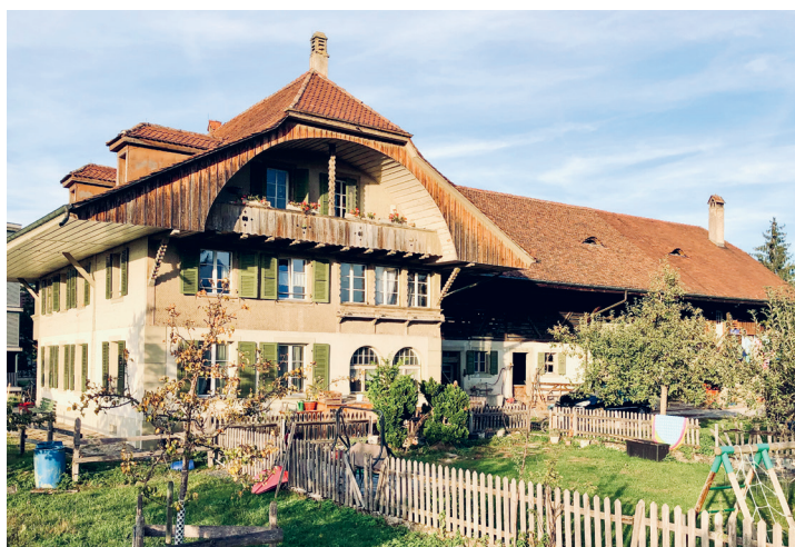
eh. Wohnhaus des Pulvermachers & Produktionsgebäude / Ansicht 2023
