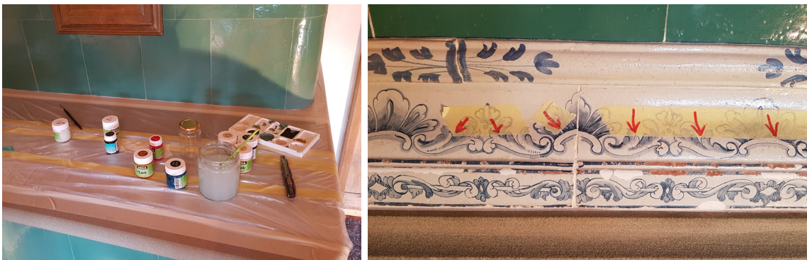
Retusche Arbeiten an der antiken Kachelhülle
