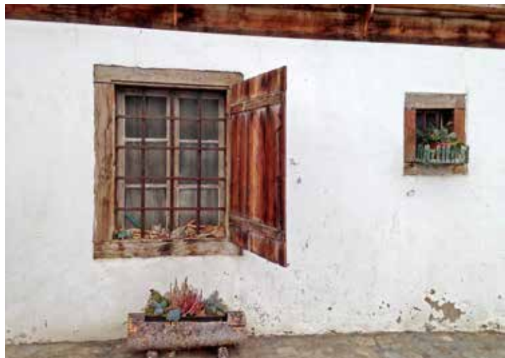
Vergittertes Chefeli-Fenster & Zellen-Fenster re. (ohne Holzkratten)
