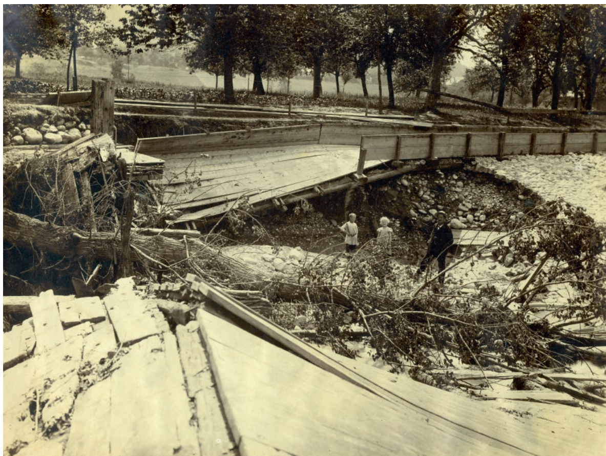
Alte Müllerschwelle Steffisburg. Zerstört durch das Hochwasser vom 25. Juli 1907. Anstoss an das linke Ufer und abgestürztes Bachteich.
