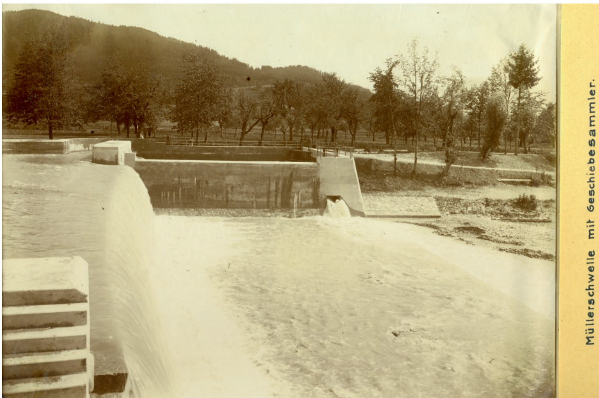
Die fertiggebaute Müllerschwelle mit dem Geschiebesammler (Bassin), Mai 1909
