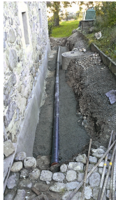
Abgedichtete Nordfassade Stöckli
