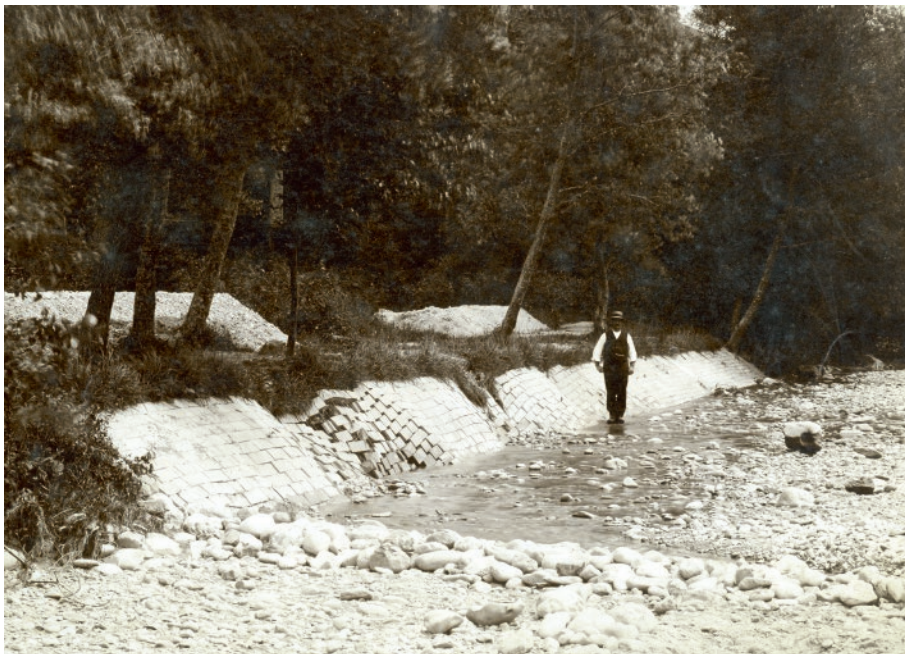
Vom Hochwasser zerstörte Décauville'sche Zulguferverkleidung, 1912
