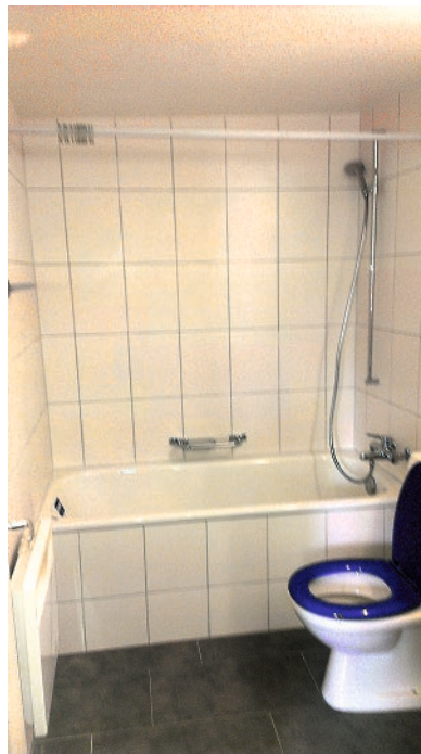
Renoviertes Bad im Stöckli
