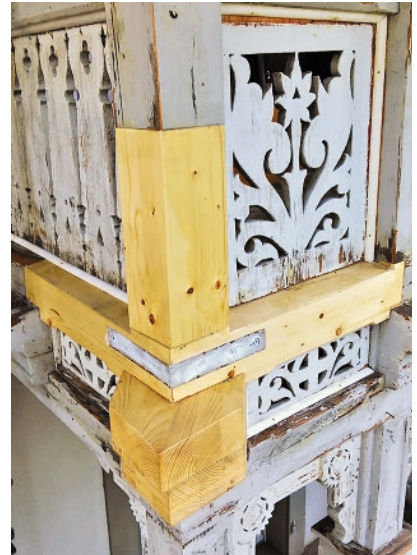
Gelungener Ersatz der faulen Holzteile.
